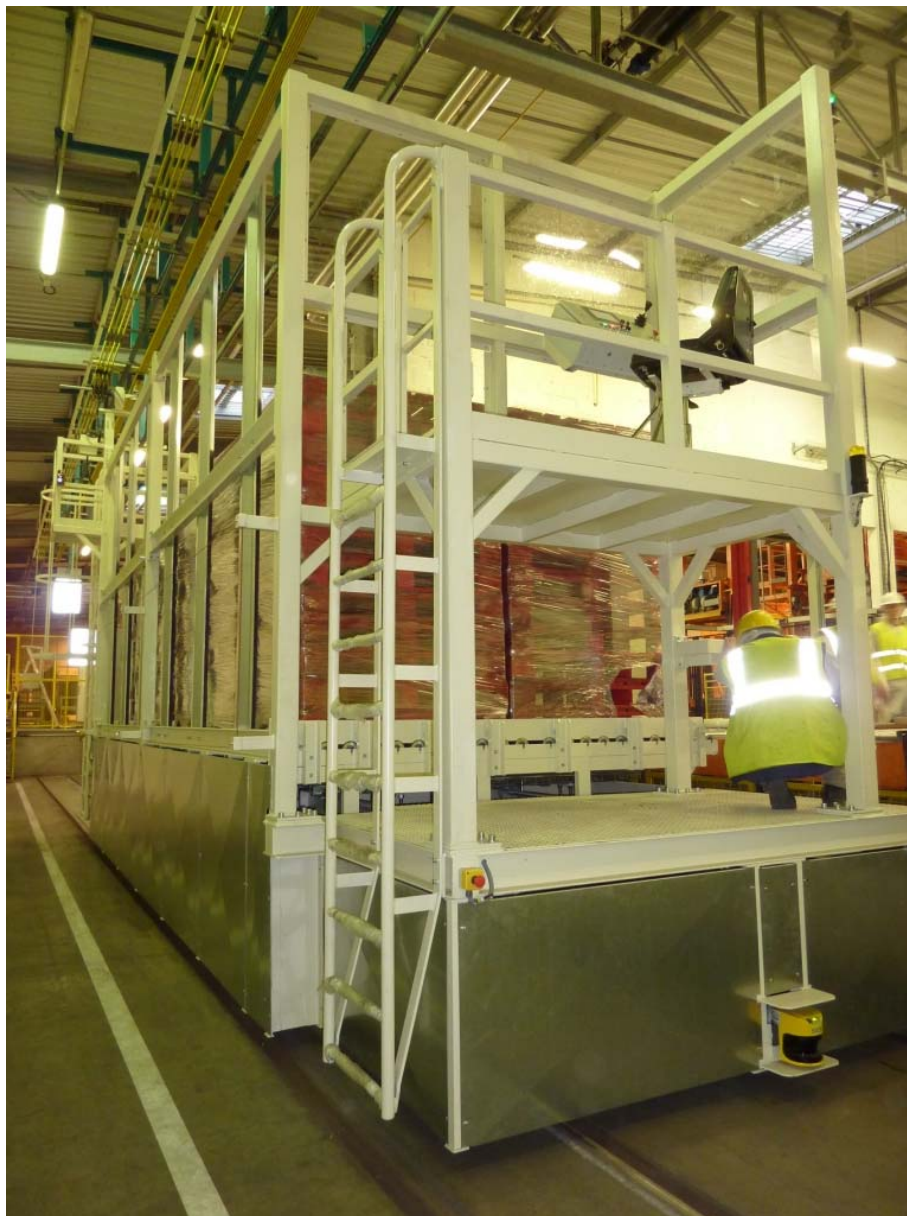
Machine en cours de mise en service sur le site client.
