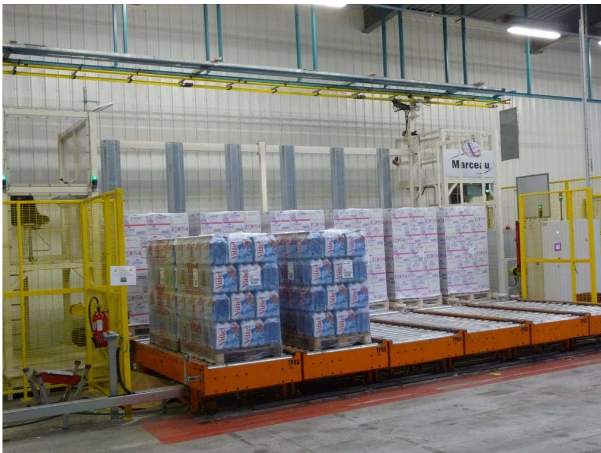
Machine en cours de mise en service sur le site client.
